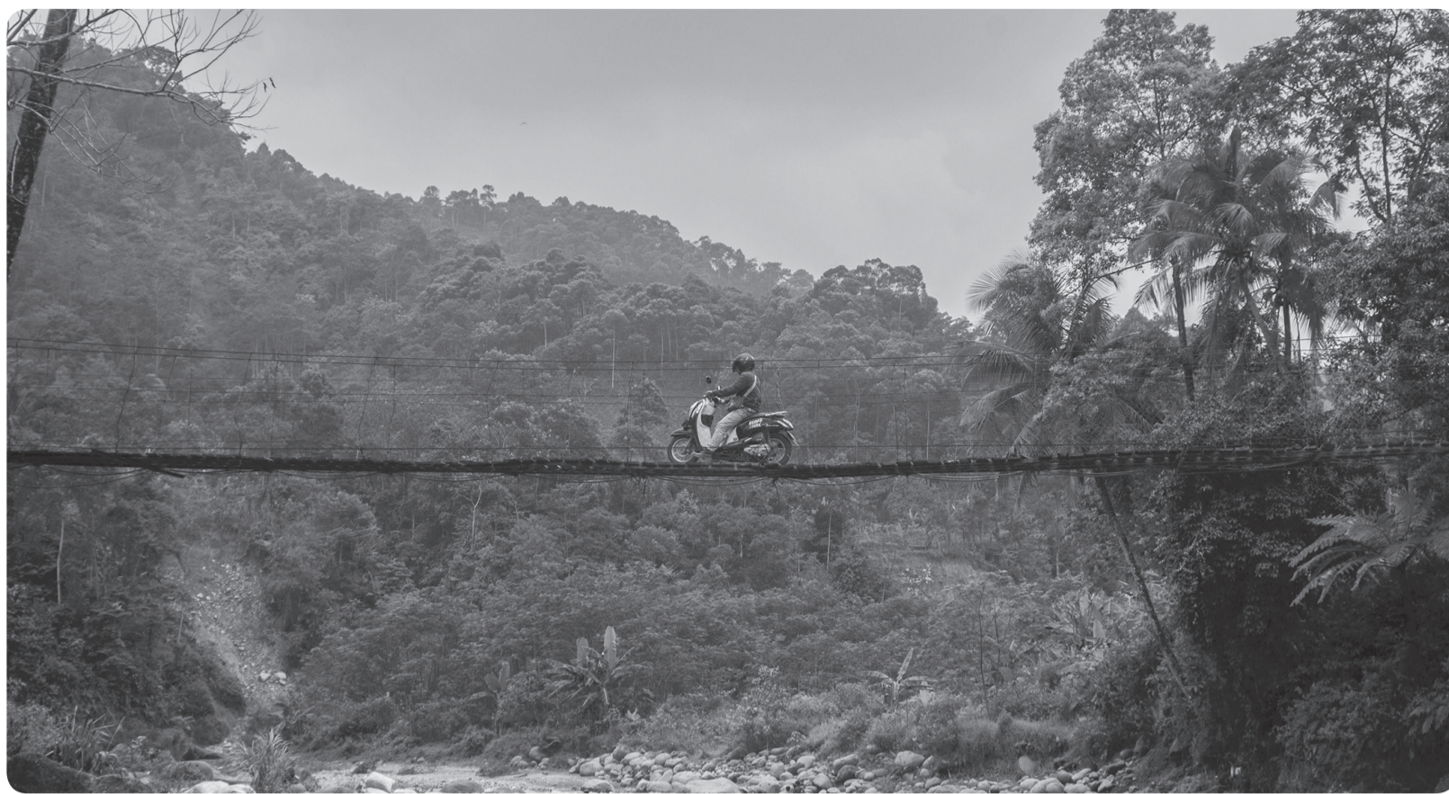
AKSES JEMBATAN TIDAK AMAN
